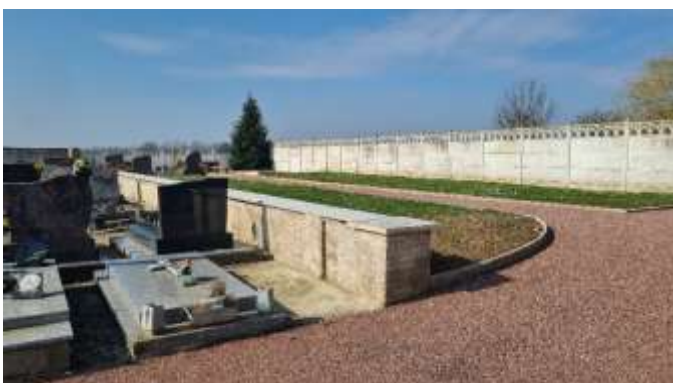
Abaissement du mur
