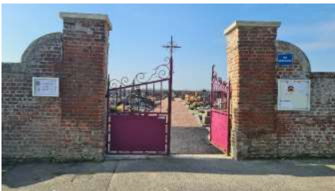
Identification du cimetière et réparation du mur
